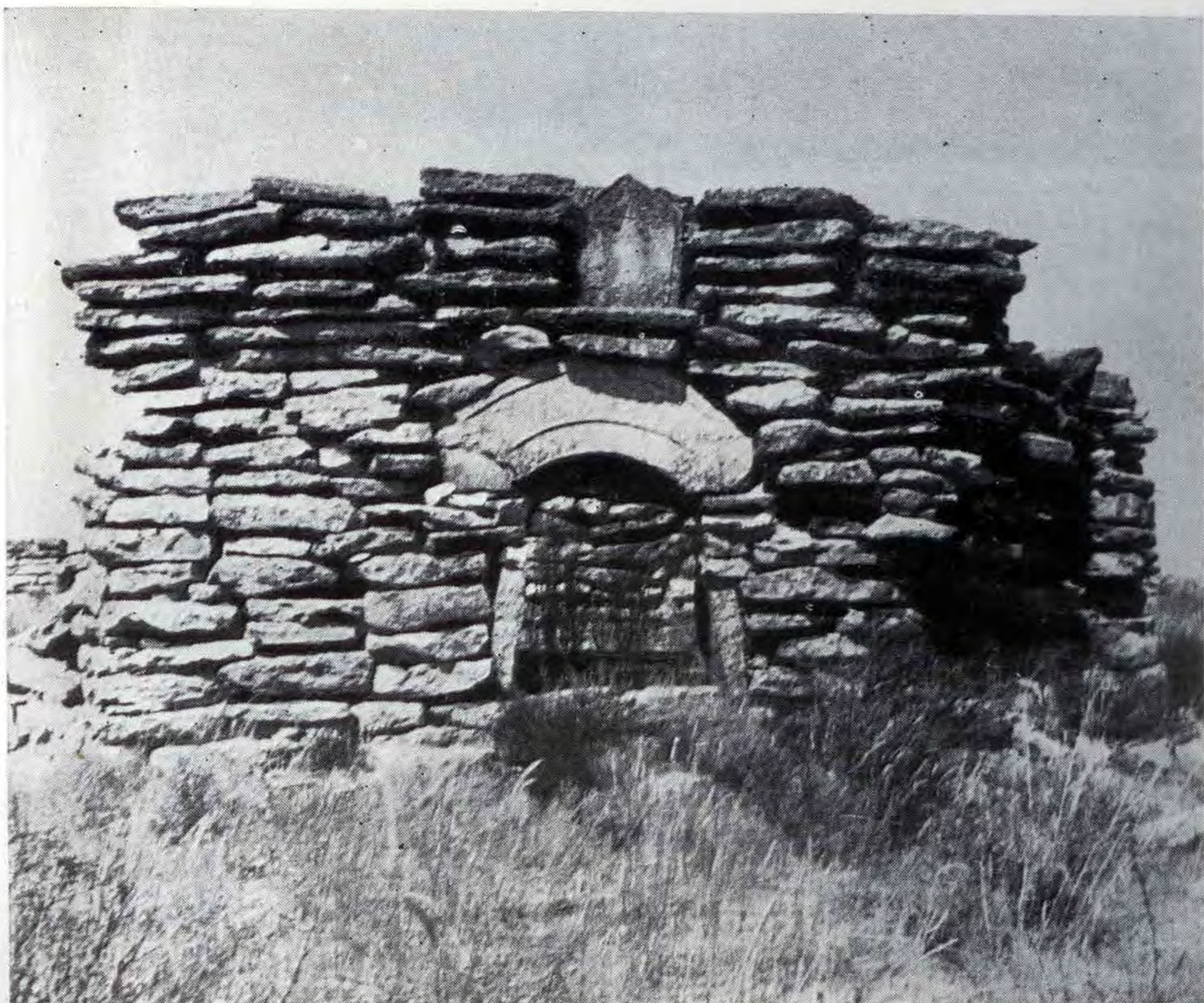
Мавзолей на некрополе Сейсен-ата. Перекрытие входного проема каменным блоком, обработанным в виде лучковой арки. XIV—XVI вв.
