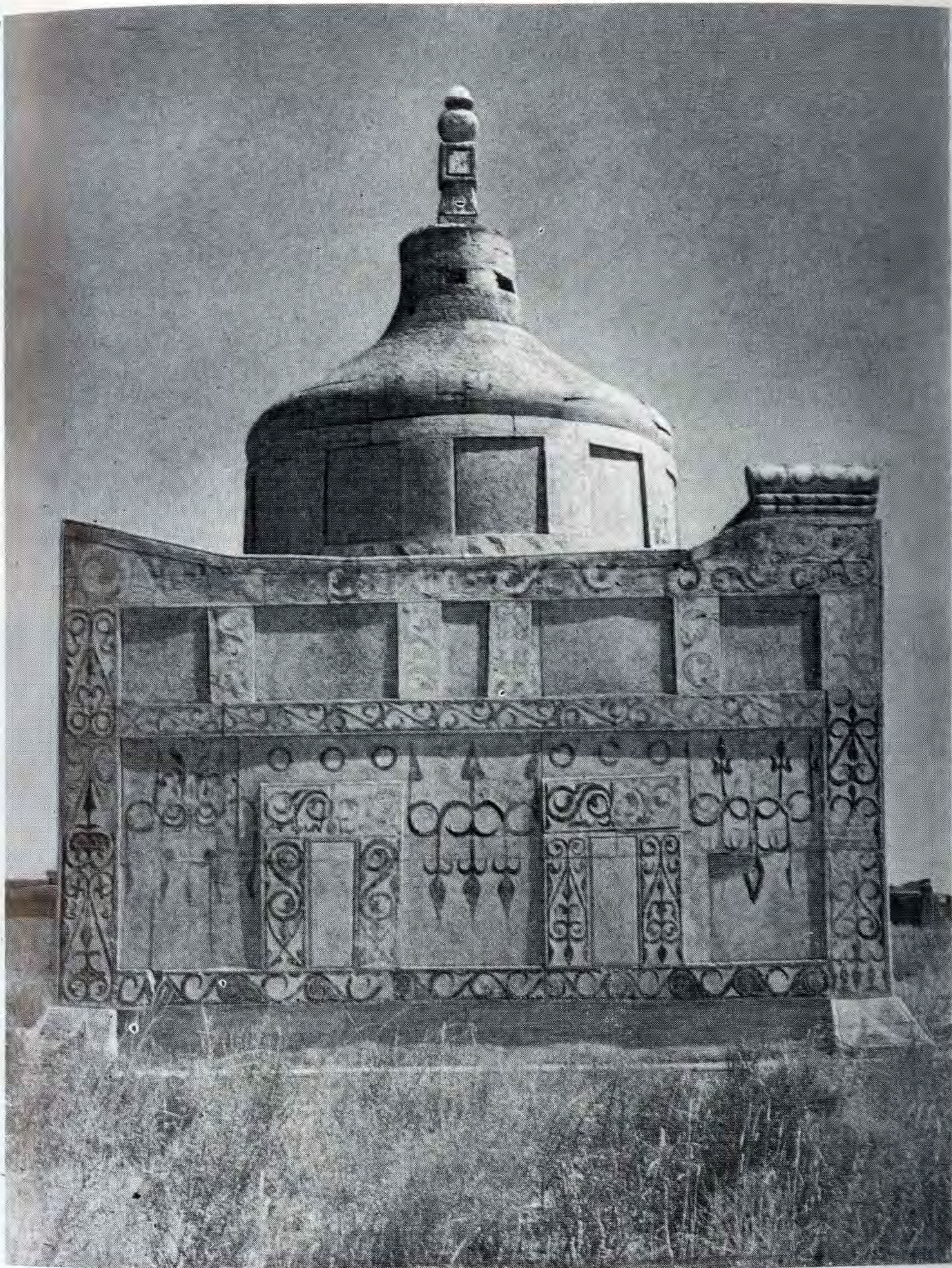
Мавзолей Шойнбая. Фото 1973 г. Мастера Умир Карин и Назар Умиров. Главный фасад. Обмер 1973 г.
