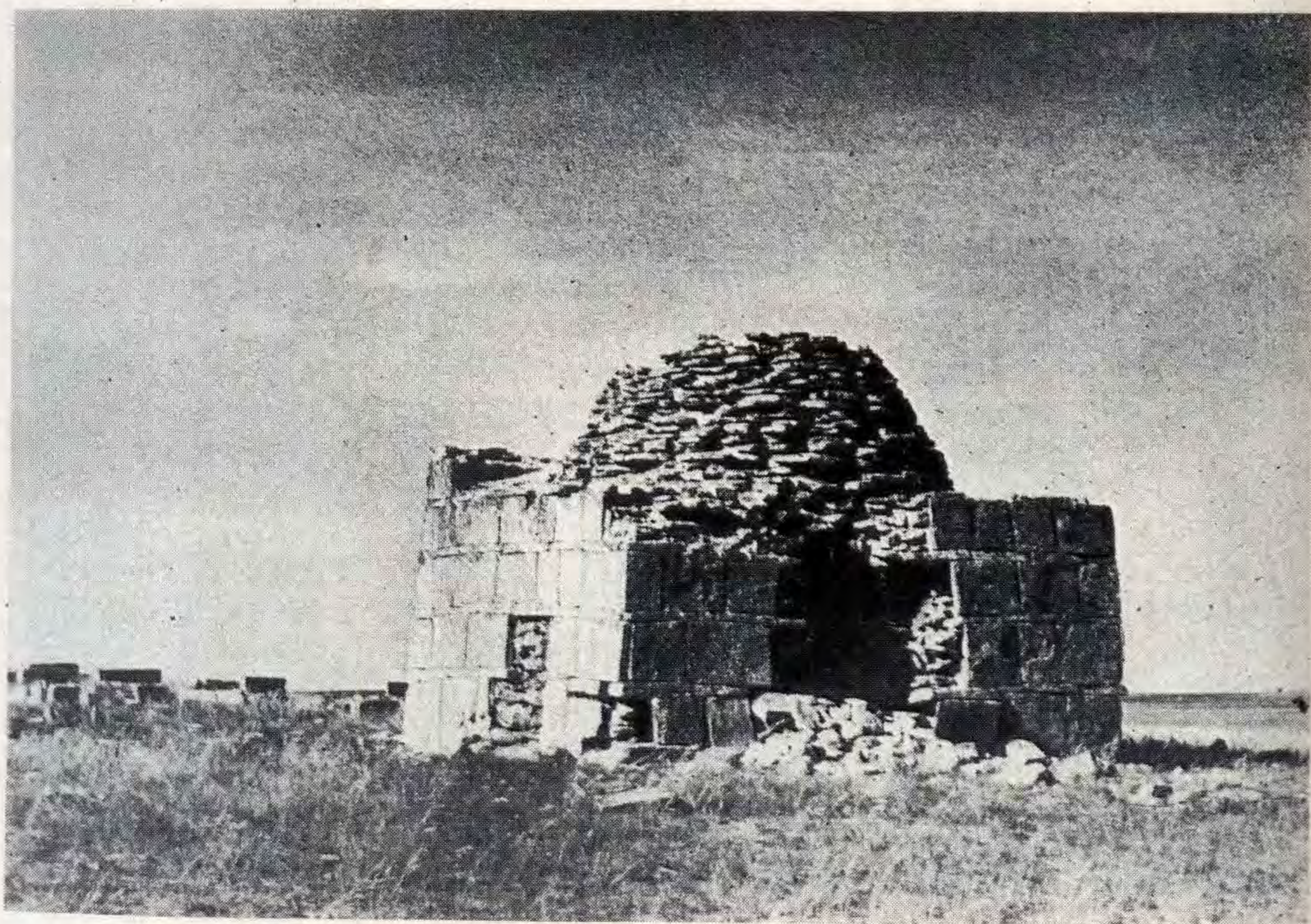
Мавзолей Акшора. Северный фасад
