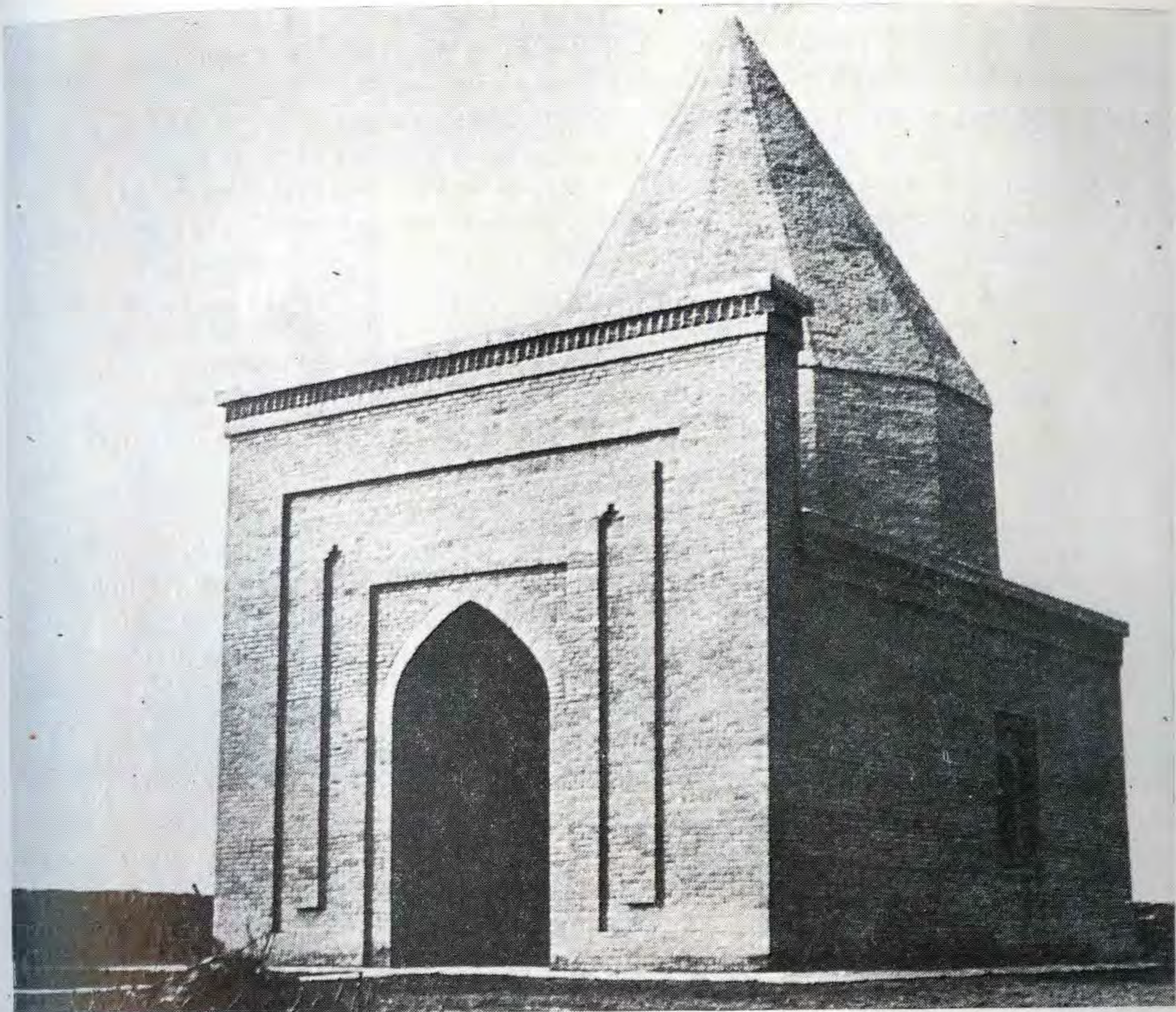
Мавзолей Кесене. Вид после реставрации. Фото 1983 г.
