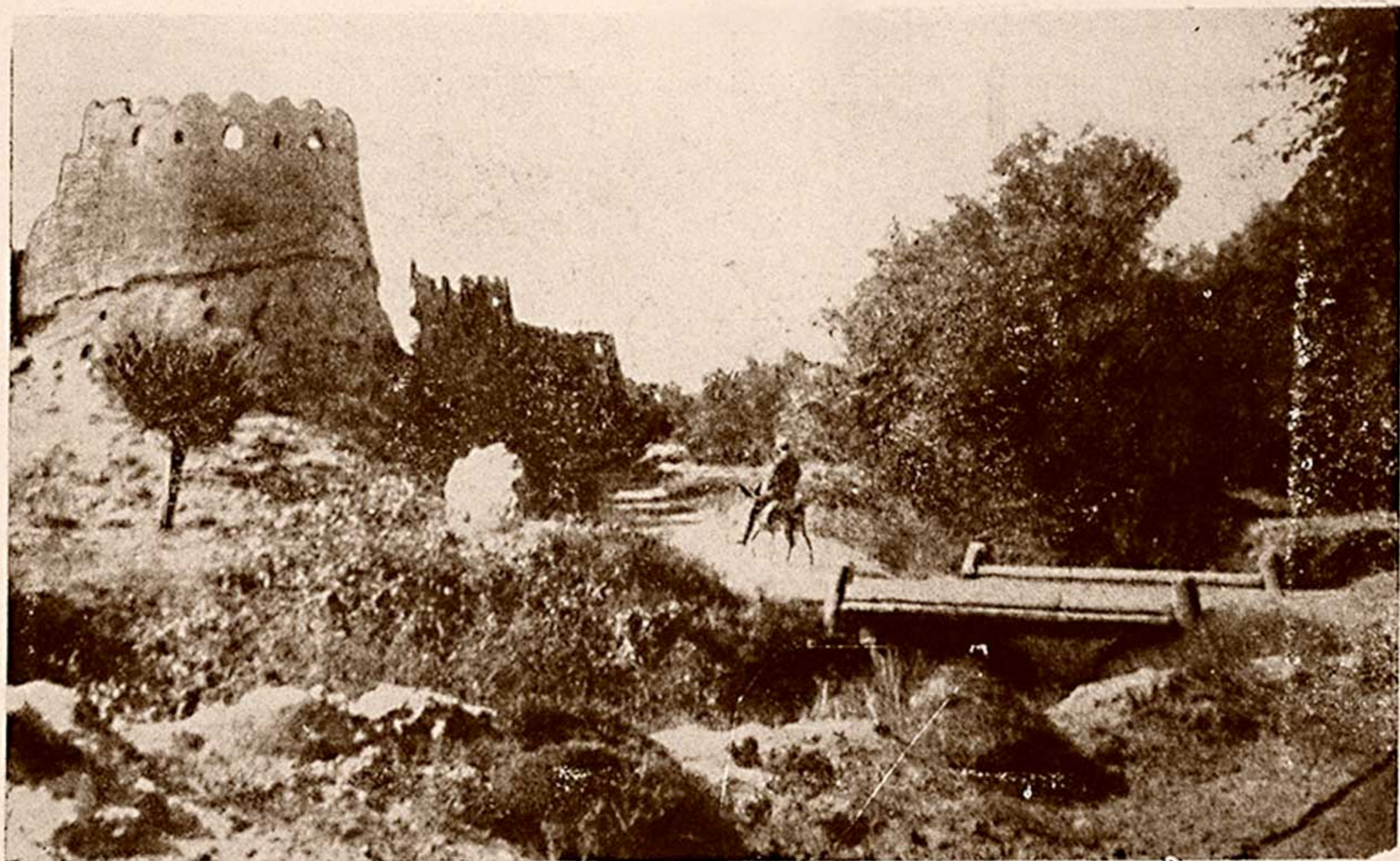
Рис. 14. Бухара. Городская стена (вид с северо-западной стороны)
