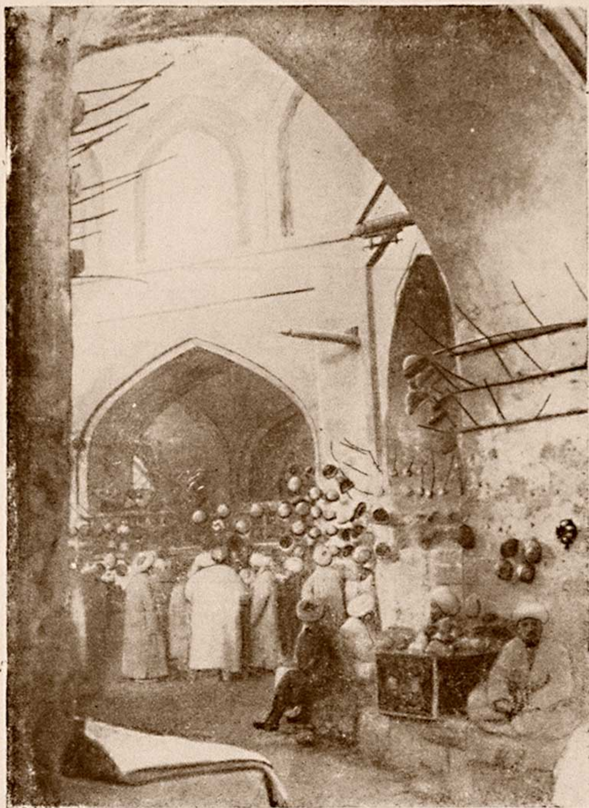
Рис. 18. Бухара. Пассаж Токи Тельпак (внутренний вид)
