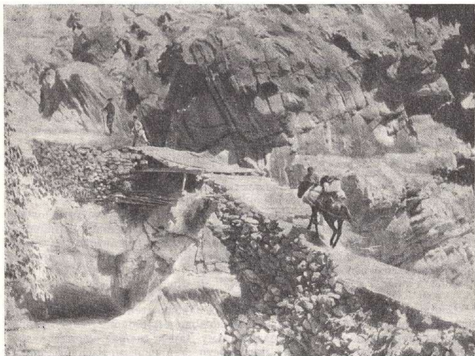
Рис. 4. Мост через р. Язгулем
