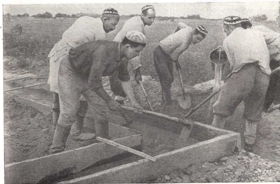
Возведение цоколя дома (к. Балхион; фото Н. С. Кармазина)
