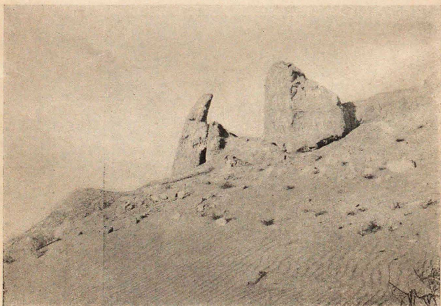
2. Городище Пейкенд. Развалины башни № 4. Вид с северо-запада.
