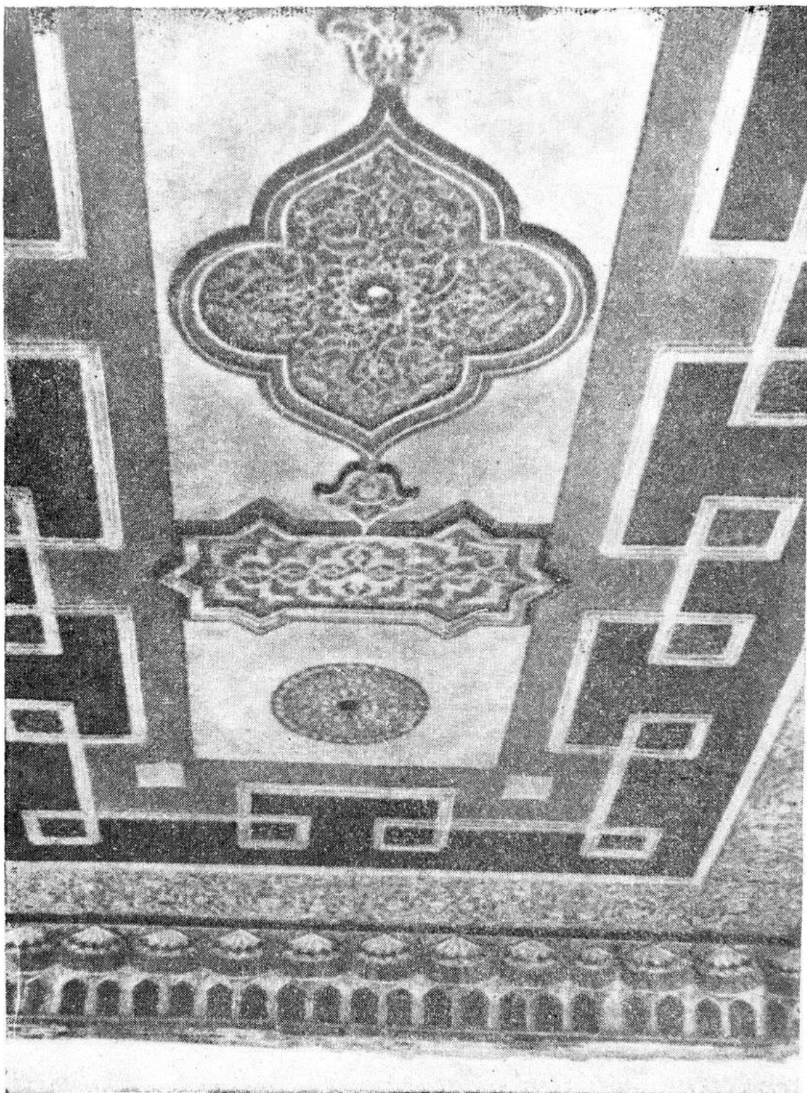
Рис. 45. Штукатурный орнаментированный потолок в доме Мир-Вафобая. Конец XIX—начало XX в.
