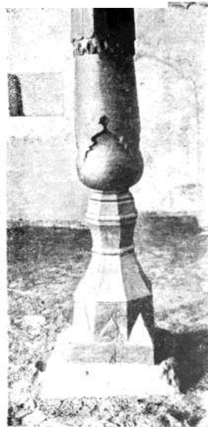
Рис. 102. Нижняя часть колонны с яблоком типа деги и базой типа мукаррари в хонако мечети Каварзор. Третья четверть XIX в.
