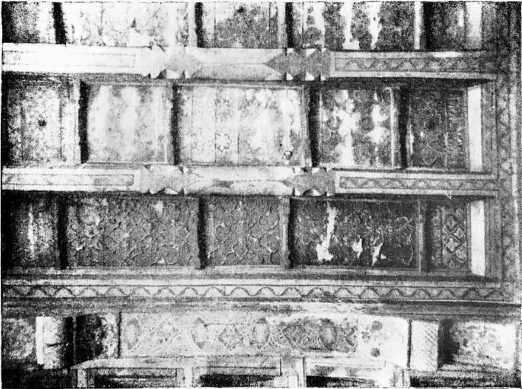
Рис. 39. Потолок типа тахта норбона на айване мечети Хавзи-Баланд. Построена в 1870 г. (1286 г. х.).
