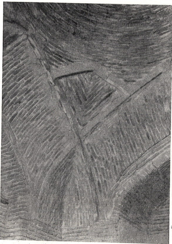
Рис. 33. Парус «тугри-гаджяк» в своде на четырех пересекающихся арках в дарвоза-хона усыпальницы кокандских ханов Дахмаи-шошон на кладбище Котта-Кабристон. Коканд. Фото Узкомстариса
