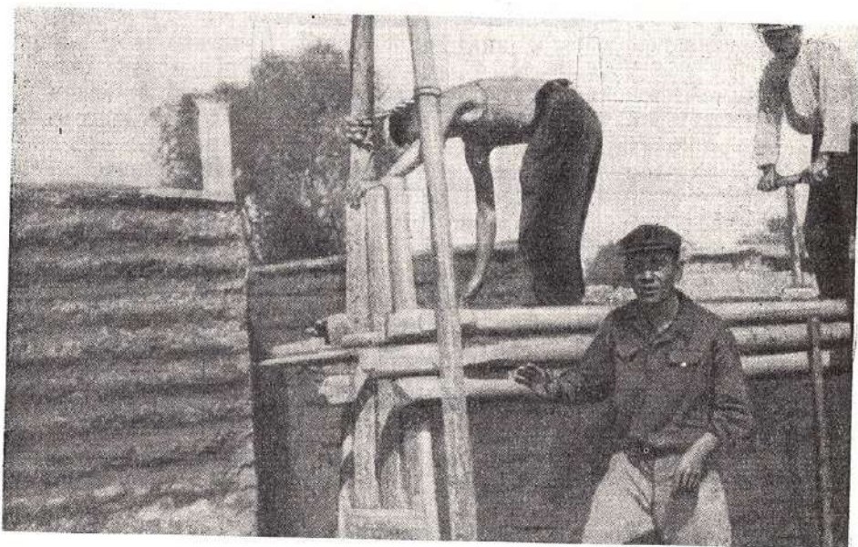
Рис. 16. Возведение стен способом «сокма». Сел. Б. Аксу, Уйгурский р-н Алма-Атинской обл.
