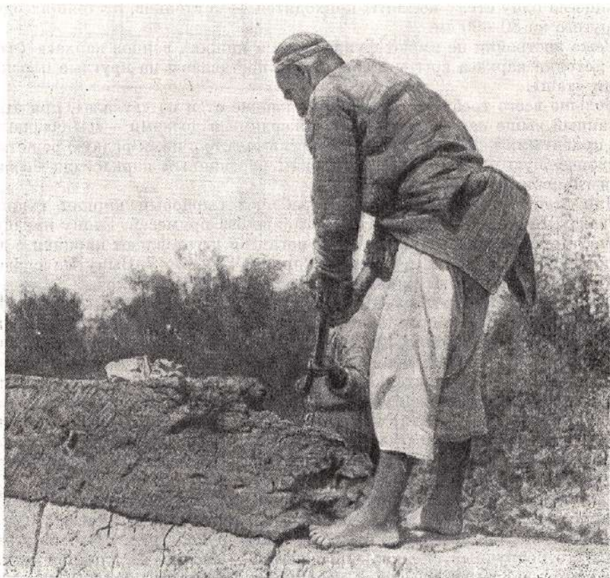
Рис. 22. Кладка пахсовой стены
