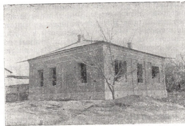
Рис. 5. Строительство жилого дома по типовому проекту.
