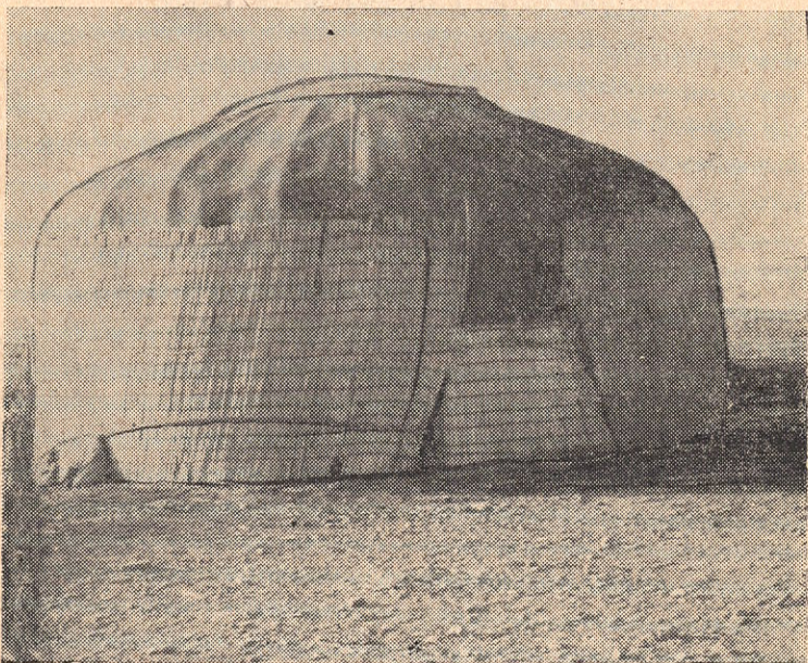
Рис. 4. Юрта со вставной камышовой циновкой „гозенок гамыш“.
