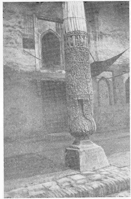
Рис. 3. Айван в медресе Мурза Баши. Колонна из вяза, высота 5,6 м, цоколь 0,4 м, капитель 0,3 м
