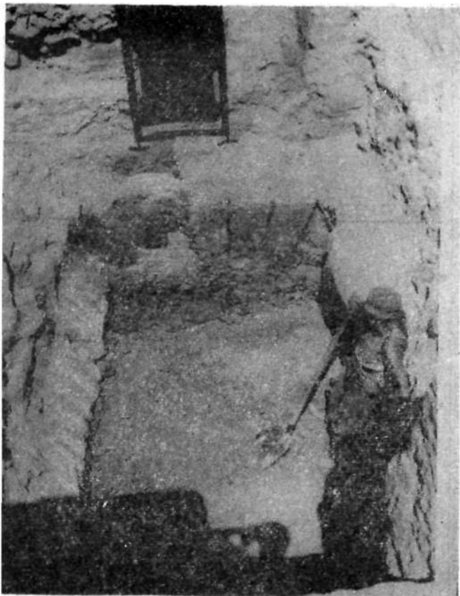
Рис. 8. Выкладка свода помещения II первого этажа замка.
