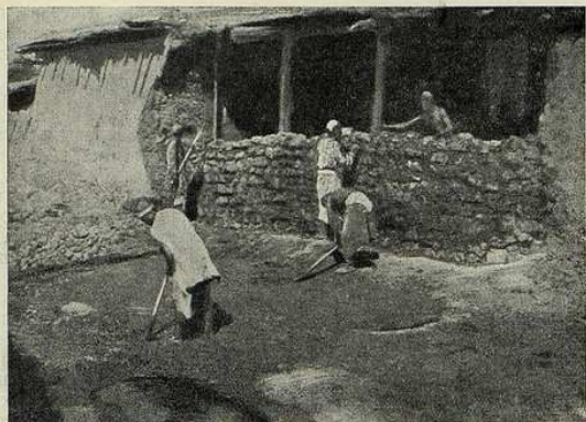
Рис. 4. Ремонт обвалившейся стены. Тип стены, складываемой из камней. Гармский район. (Фото Е. Крючкова.)
