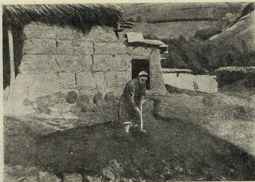
Рис. 3. Ремонт обвалившейся стены. Тип стены, сложенной из лѣсса. Гармский район. (Фото С. Абрамзона.)
