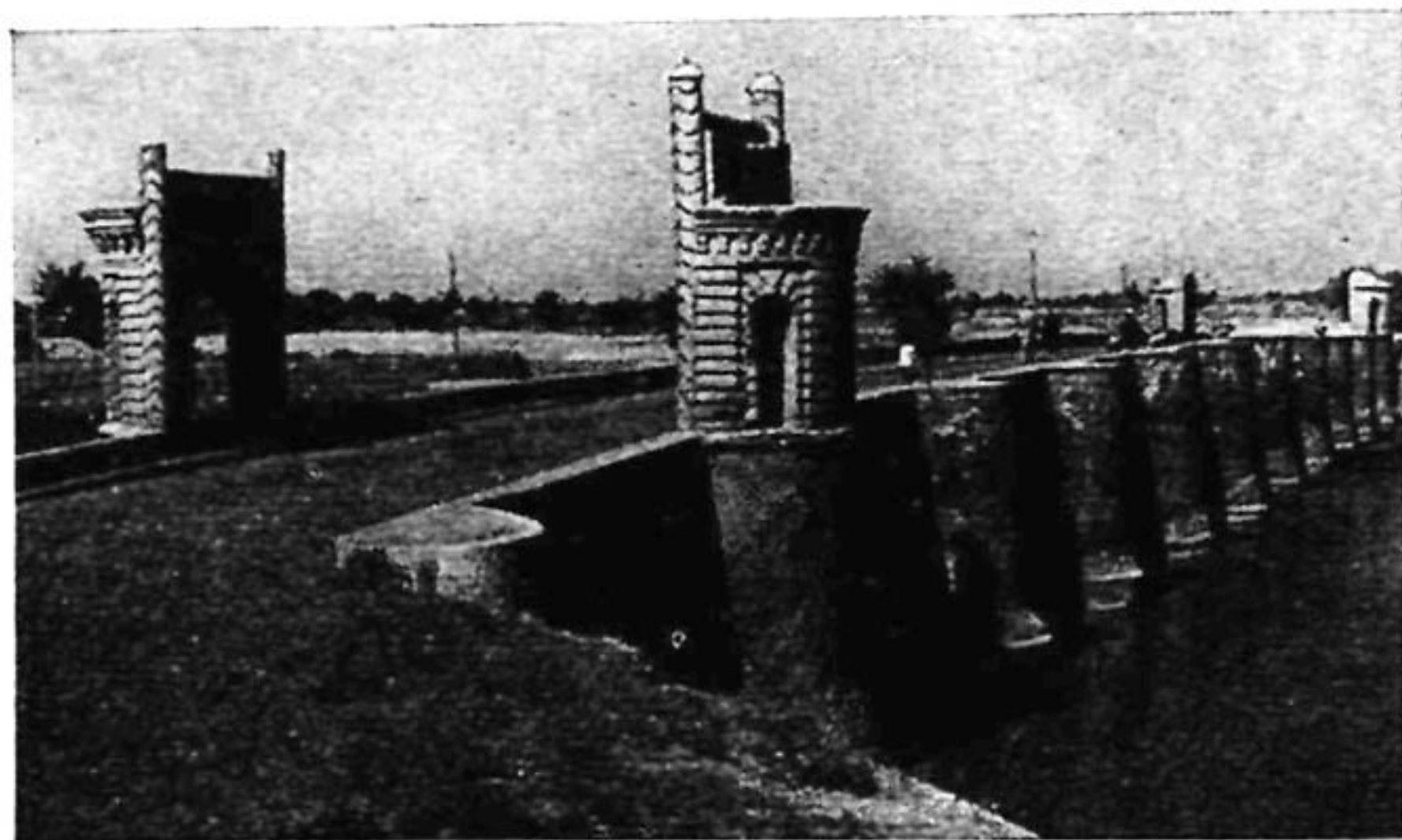
Рис. 9. Карши. Бухарский мост через Кашкадарью (фото В. Н. Гришберга)
