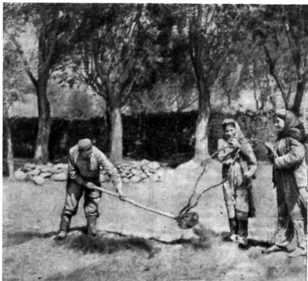
Рис. 19. Чистка арыка при помощи веревки «анджаи»
