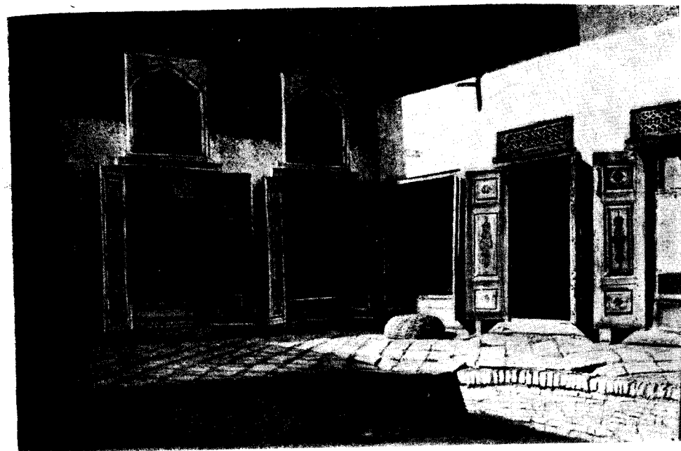
Рис. 8. Бухарский дом с открытыми террасами
