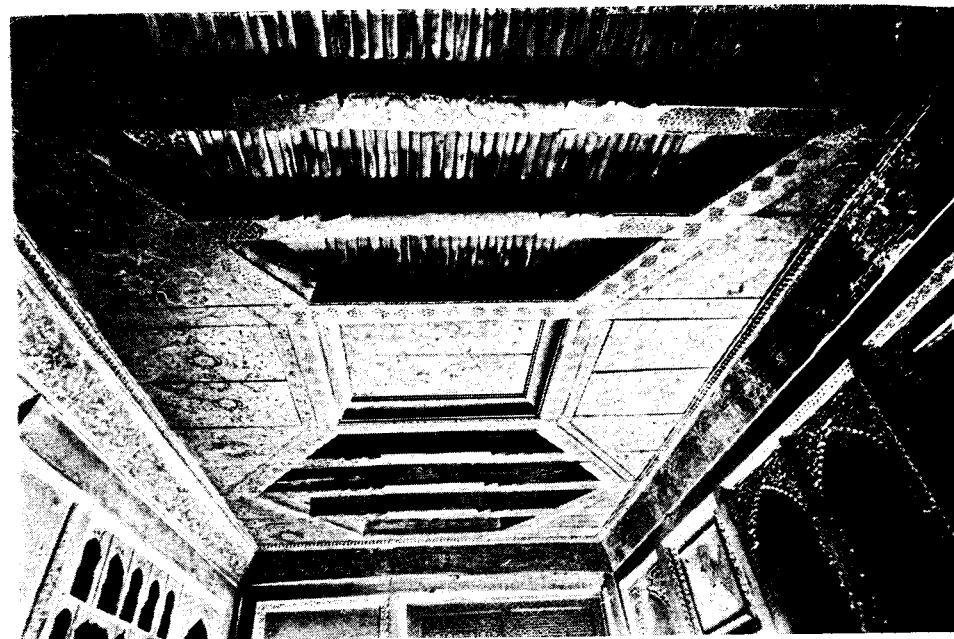
Рис. 89. Потолок дома Ахмаджона в Ташкенте. 1848 год. Сочетание балок, ваза и дощатых плоскостей, роспись и резьба
