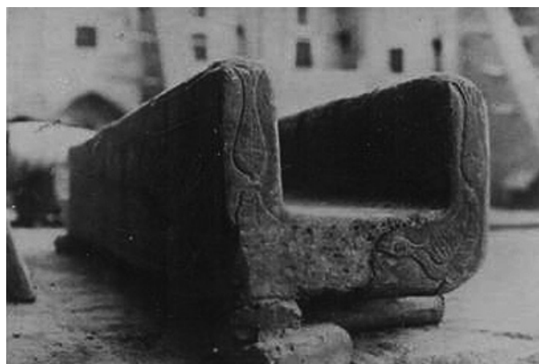
12. Водослив хауза Рашид в Бухаре. Общий вид
