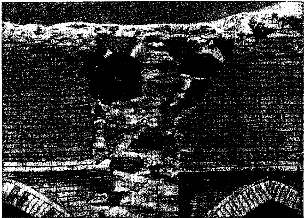
Рис. 5. Дая-Хатын. Вид воздухопроницаемых отверстий в потолке вдоль стен.
