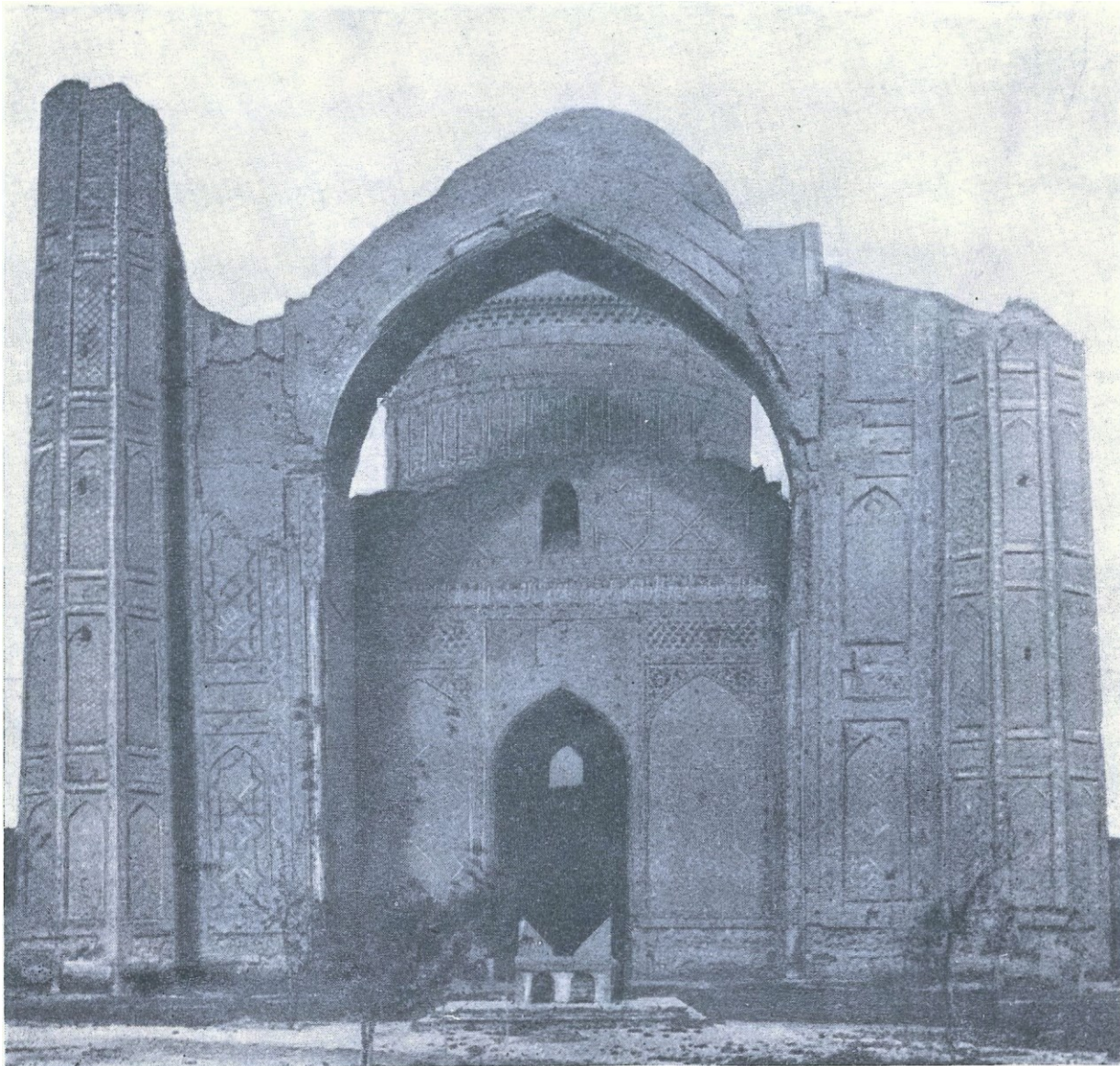
Рис. 24. Восточный фасад главного здания мечети.
