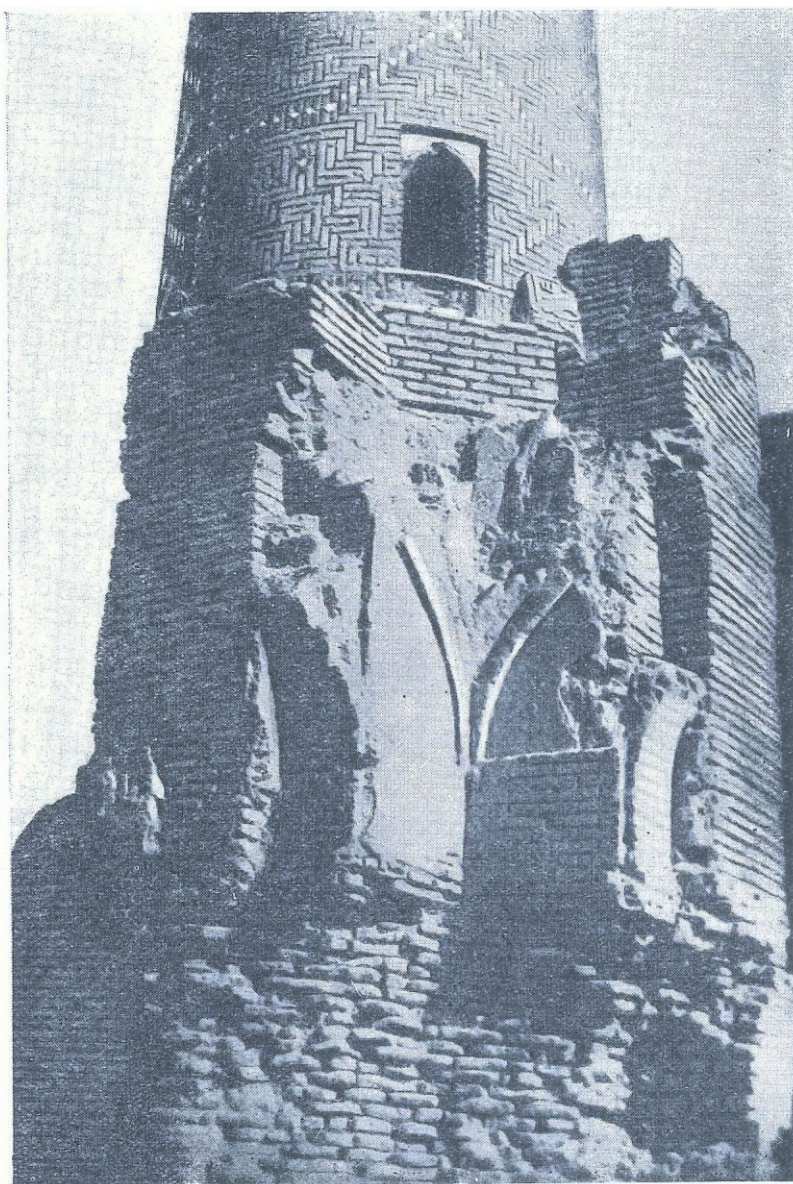
Рис. 48. Основание минарета со следами примыкания онеших стен мечети.
