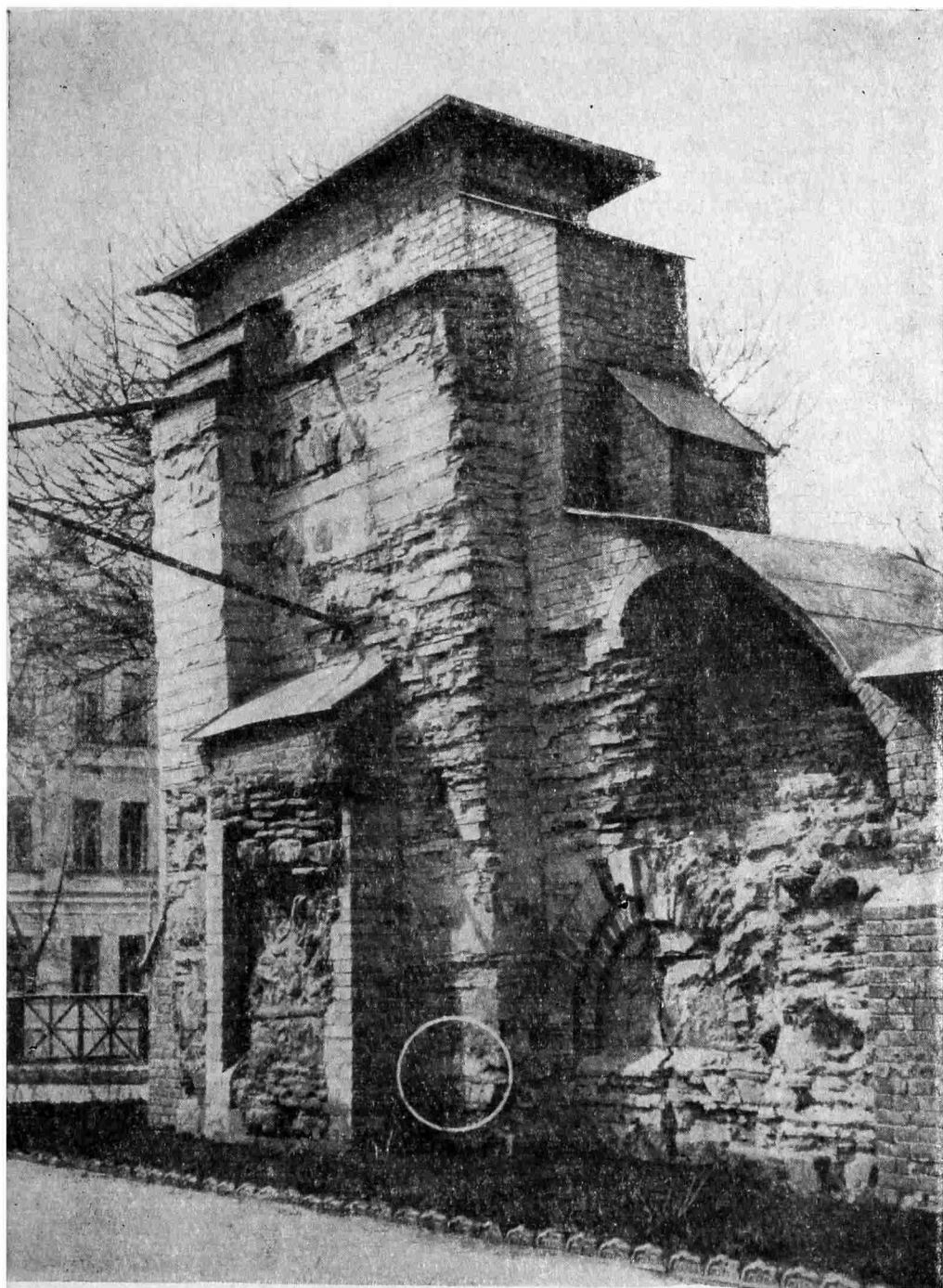
Рис. 1. Руины западной стены Золотых ворот в г. Киеве. Кругом обозначено место находок граффити
