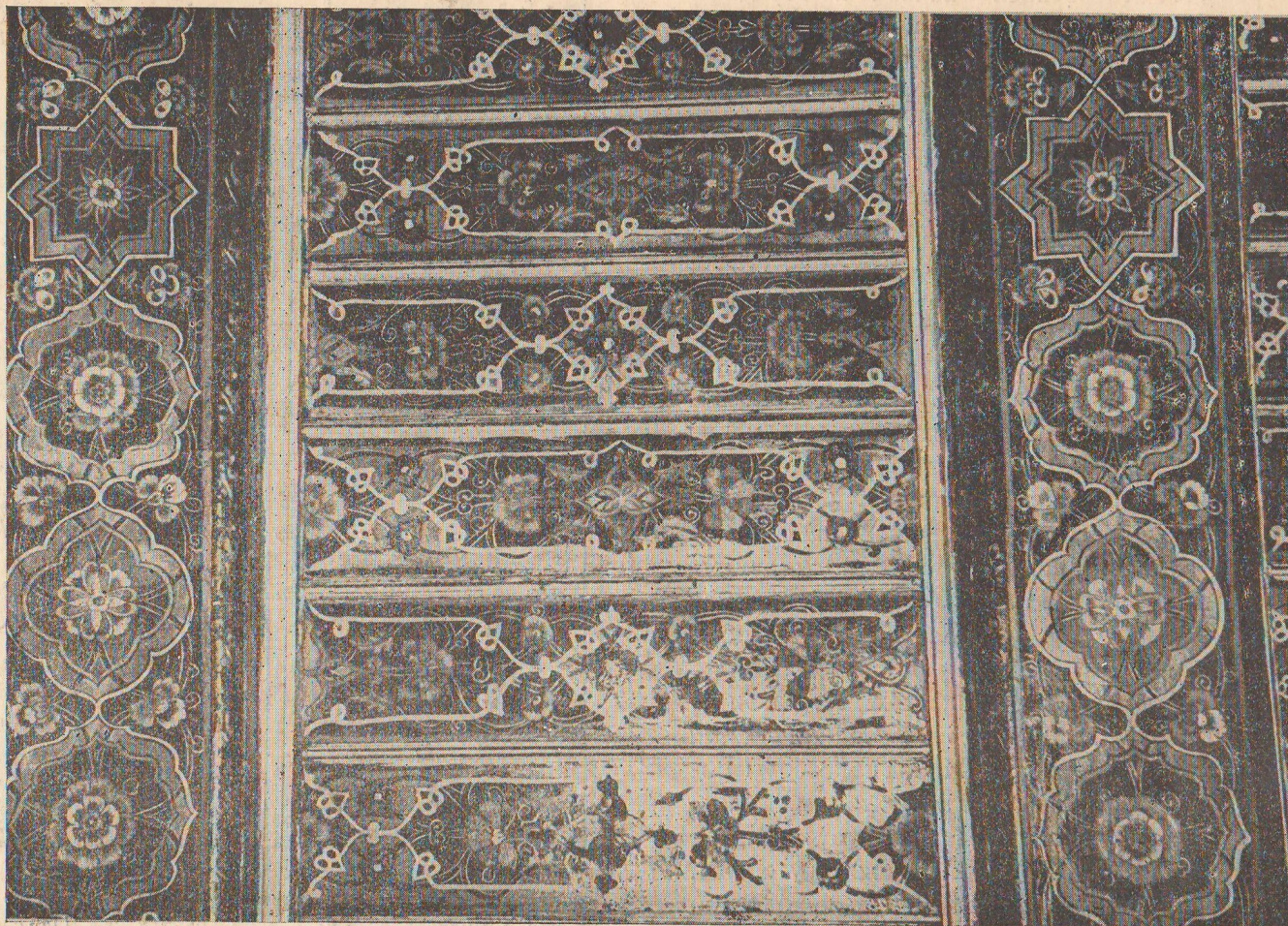
Рис. 4. Образец художественно-декоративной обработки потолка: балки (боша), расписанные с трех сторон, и узорные бруски (васа) потолочного настила. Дворец Н. К. Романова, ныне Дворец пионеров им. И. В. Сталина (Ташкент, конец XIX века). Роспись усто Шерали Ходжа Хасанова и А. Касымджанова.
