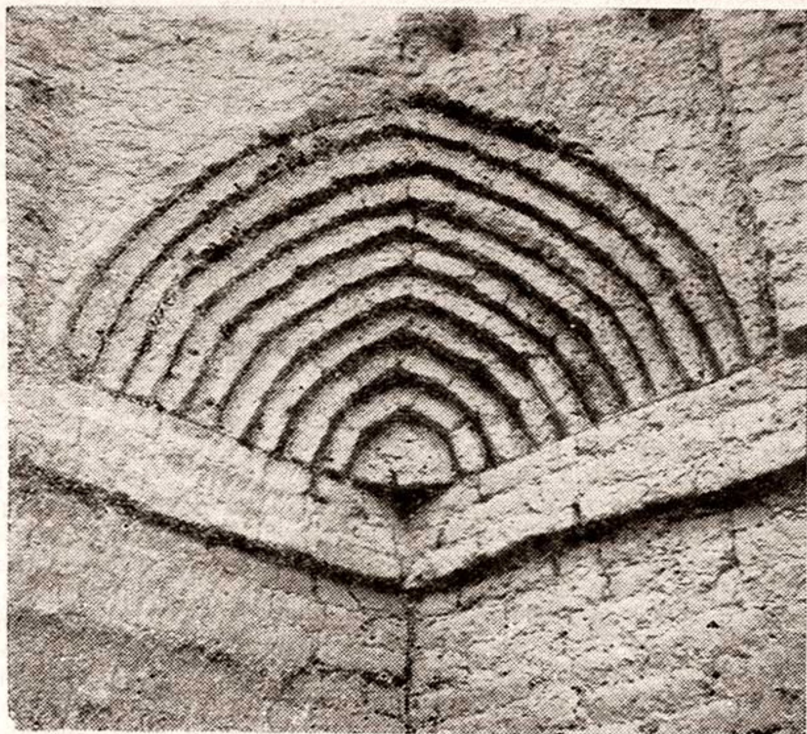
Рис. 13. Угловой тромп мавзолея Кыз-биби.
