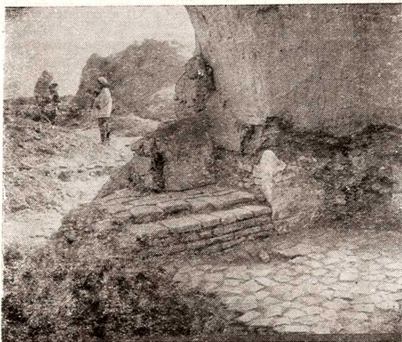
Рис. 11. Поздняя вымостка и закладка арки в мавзолее Кыз-биби.
