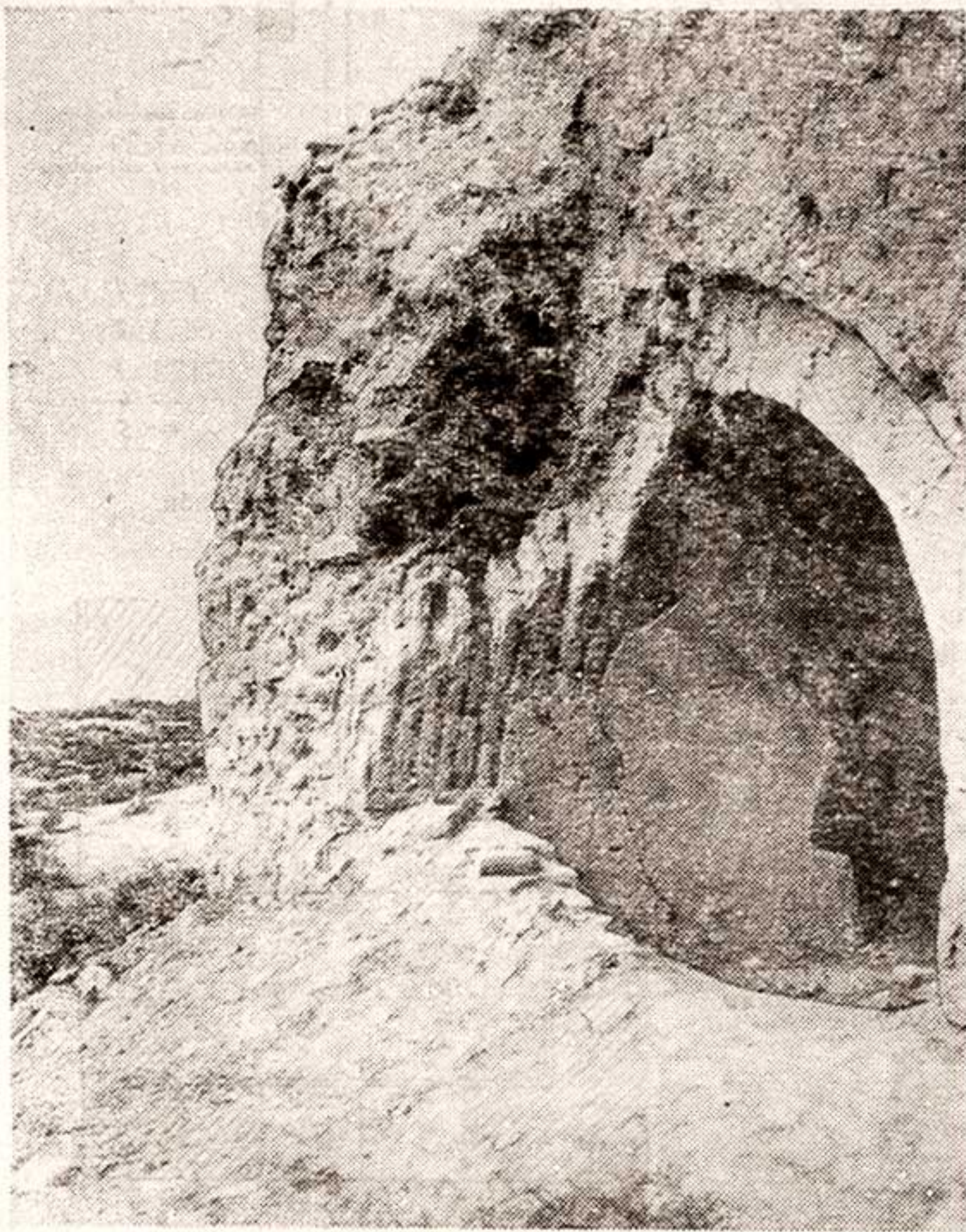
Рис. 10. Южная арка мавзолея Кыз-биби. Видна ремонтная прикладка.
