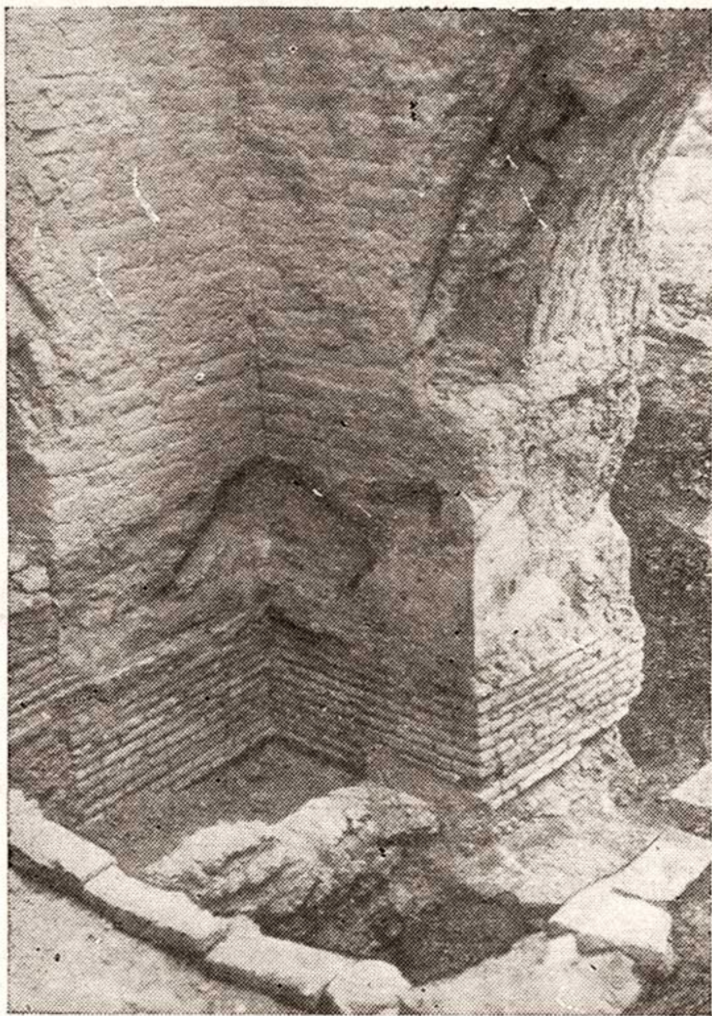
Рис. 12. Северо-восточный угол мавзолея Кыз-биби. Внизу виден цоколь из жженных кирпичей.
