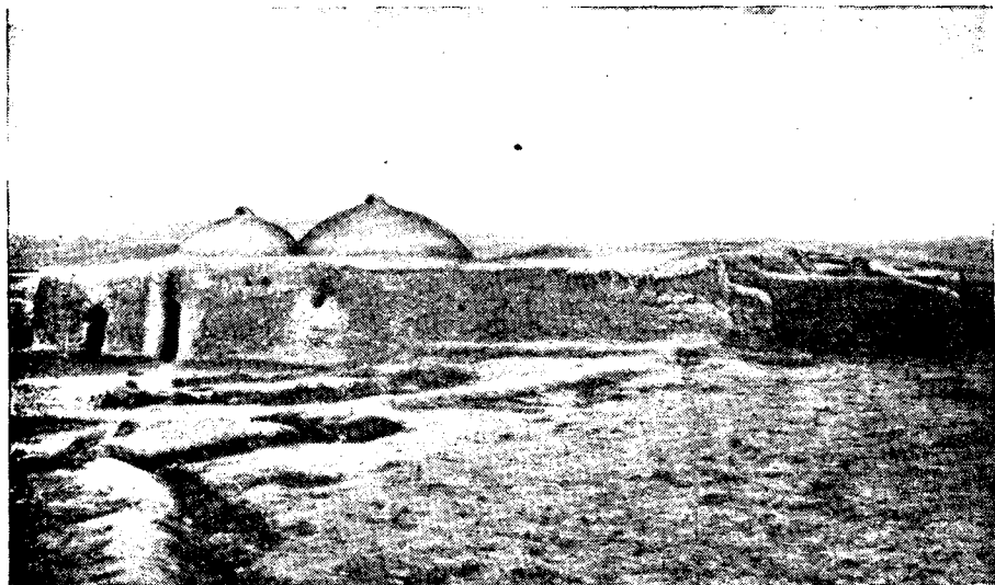
Рис. 14. Дом зажиточного джемшида из кирпича - сырца, с куполами. Сзади к дому пристроены хлева. Фото МАЭ, 3888—3
