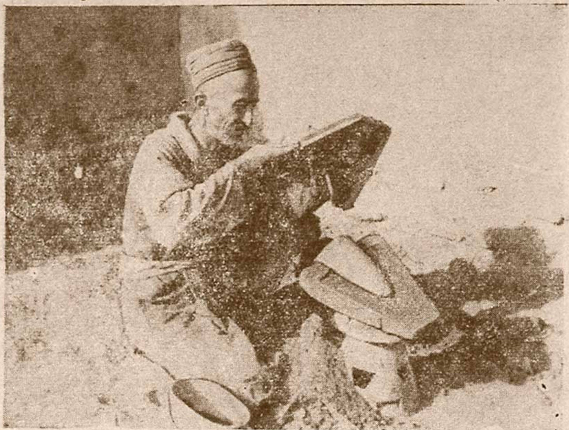
Рис. 5. Приготовление формы сошника.
