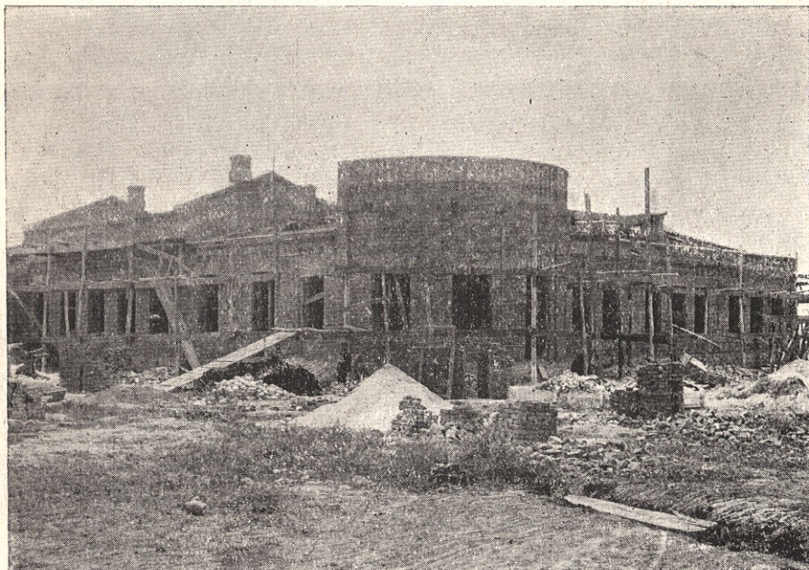
Строящаяся школа в Сталинабаде.
