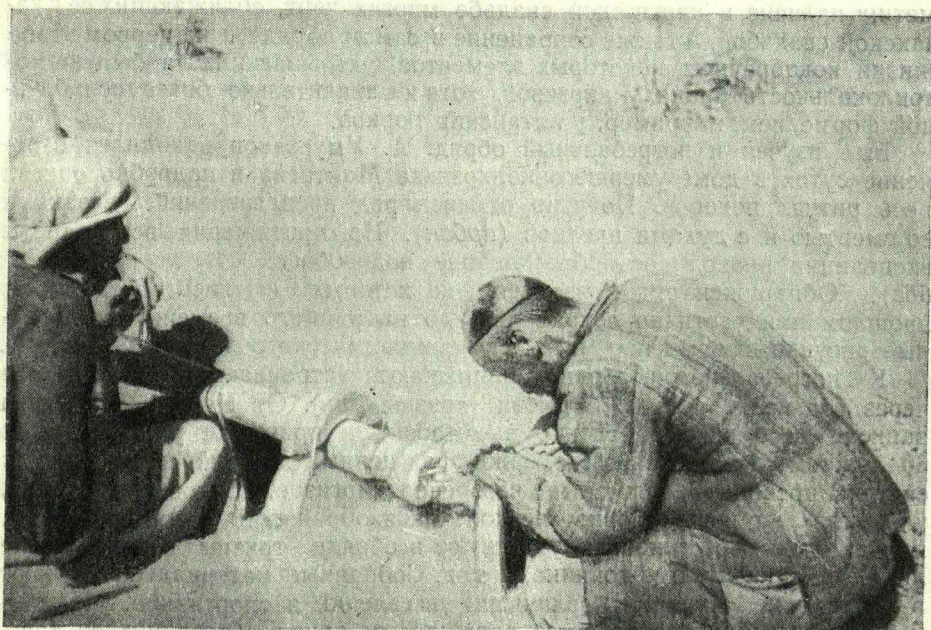
3. Мастер (кырмачы) Акмат Мадыбаев, изготавливающий деревянную посуду на простейшем токарном станке Колхоз „Чонг-арык“, Куланакского района
