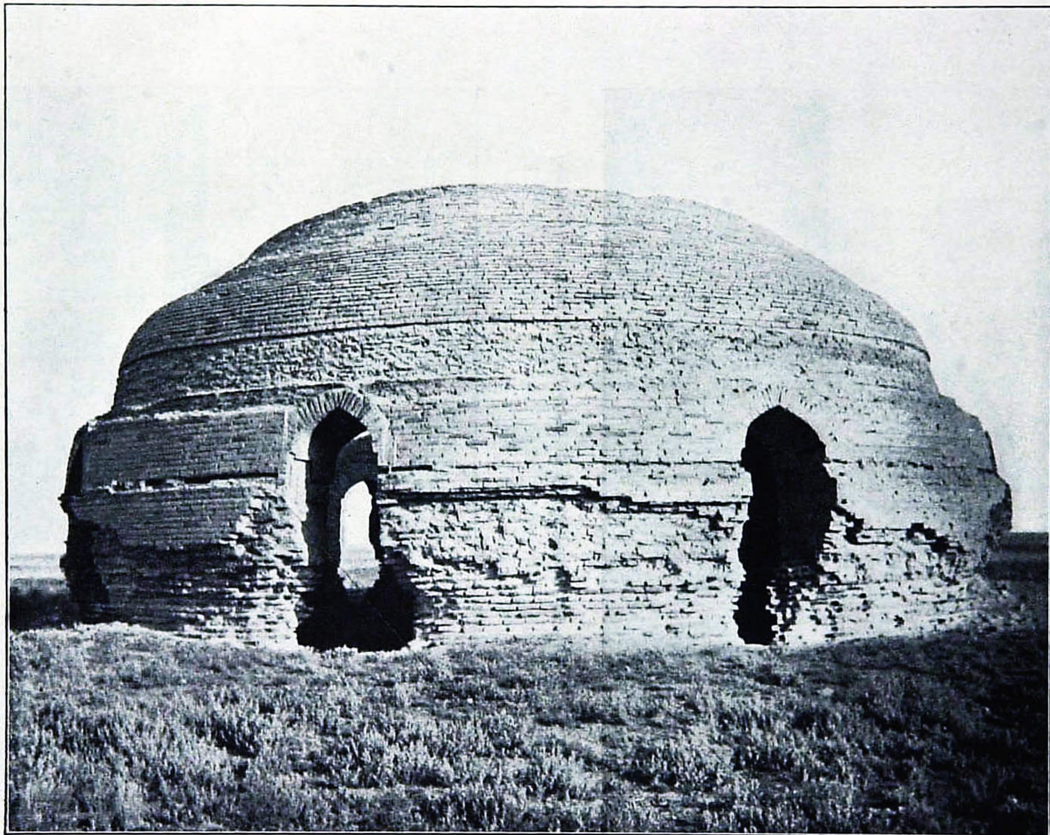
Туземная постройка из жженого кирпича над колодезём въ мѣстности Якка-Сардоба въ Голодной Степи.
