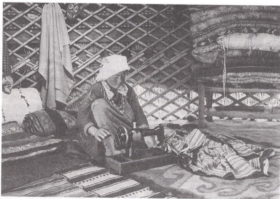
Рис. 2. Место стыка двух соседних звеньев решетки и двух ее ярусов (см. на рисунке за спиной женщины). Кишлак Баташ Шурчинского р-на Сурхандарьинской обл. Узбекистана. 1971 г.
