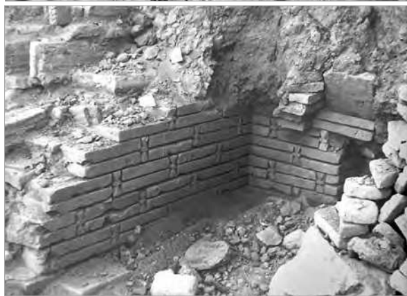
Рис. 42. Основание портальной ниши медресе Кусамийи: а — южный пилон, б — северный пилон портала
