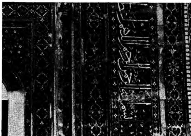
Фрагмент облицовки фасада мавзолея Туман-ака
