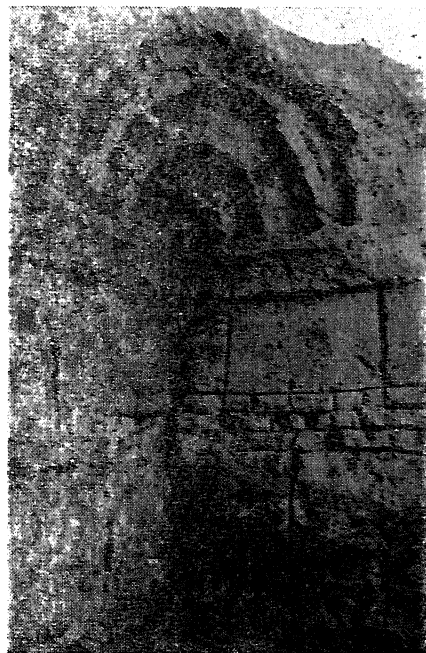
Рис. 6. Фрагмент стены в помещении с куполом.
