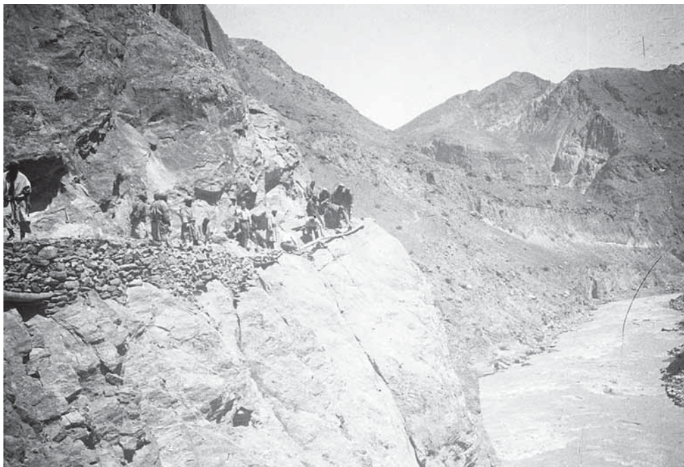
Рис. 3. Работа русских саперов по разработке дороги в Дарвазе. Стереоскопический негатив. Памир. Памирцы. И. И. Зарубин. 1914 г. МАЭ № 2372-162
