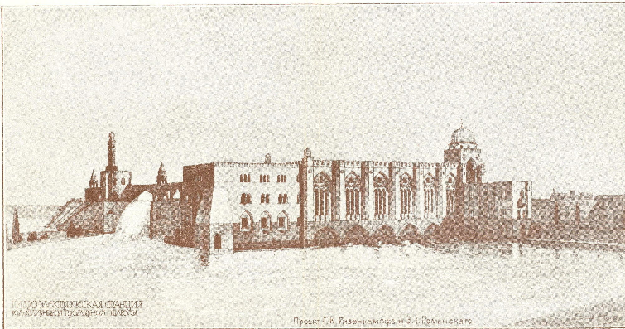
Беговатская гидроэлектрическая станция в Туркестане мощностью в 23.500 установленных лошадиных сил на валу турбин. — По плану, разработанному Государственной Комиссией по Электрофикации России. — Беговатская станция подлежит осуществлению в первую очередь.
