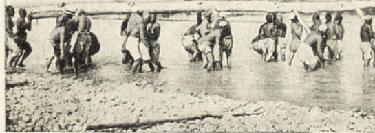
Ирригационные работы. Установка шпана (козла)
