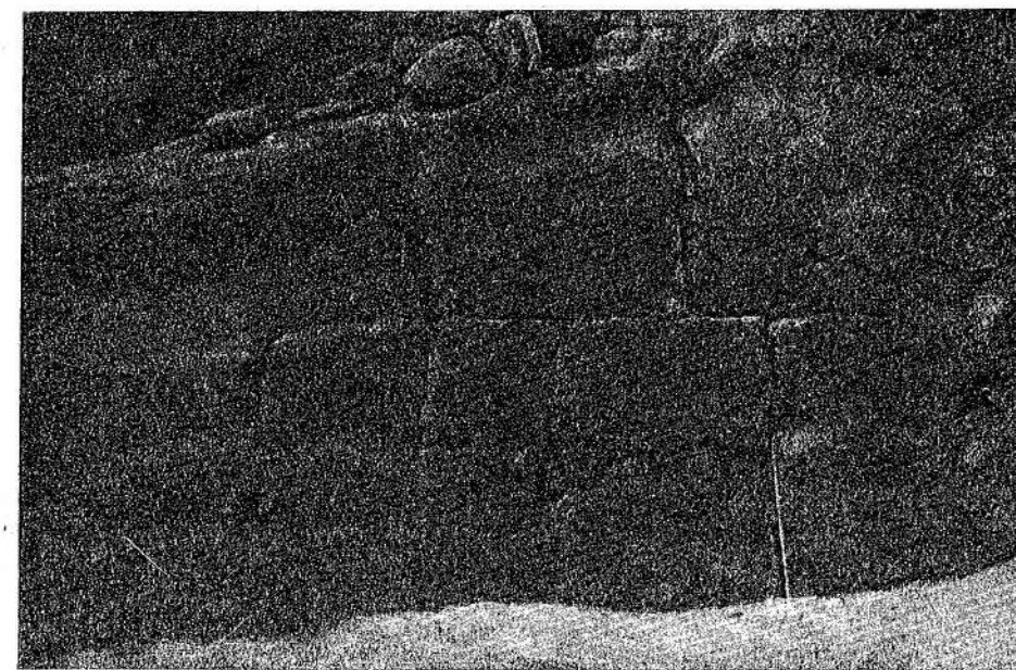
Рис. 20. Пригород. Дом № 9. Стена из пахсовых блоков.
