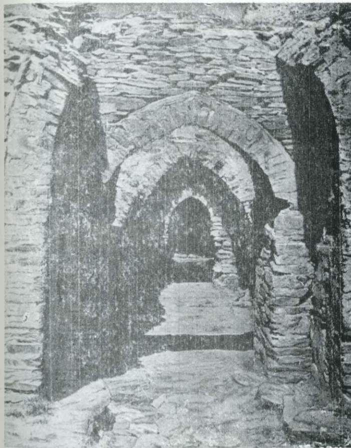
Рис. 3. Портальная арка. Вход в здание.
