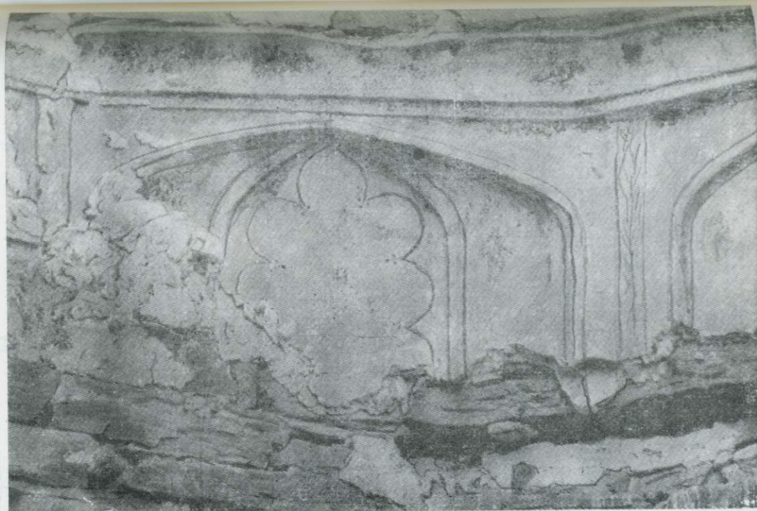
Рис. 17. Подкупольные конструкции квадратного зала. Тромп с граненой оболочкой в углах грани: слева — остатки декоративного столбика; справа — насечки на штукатурке для «примораживания» детали на растворе.
