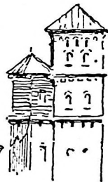
Трещина после землетрясения
