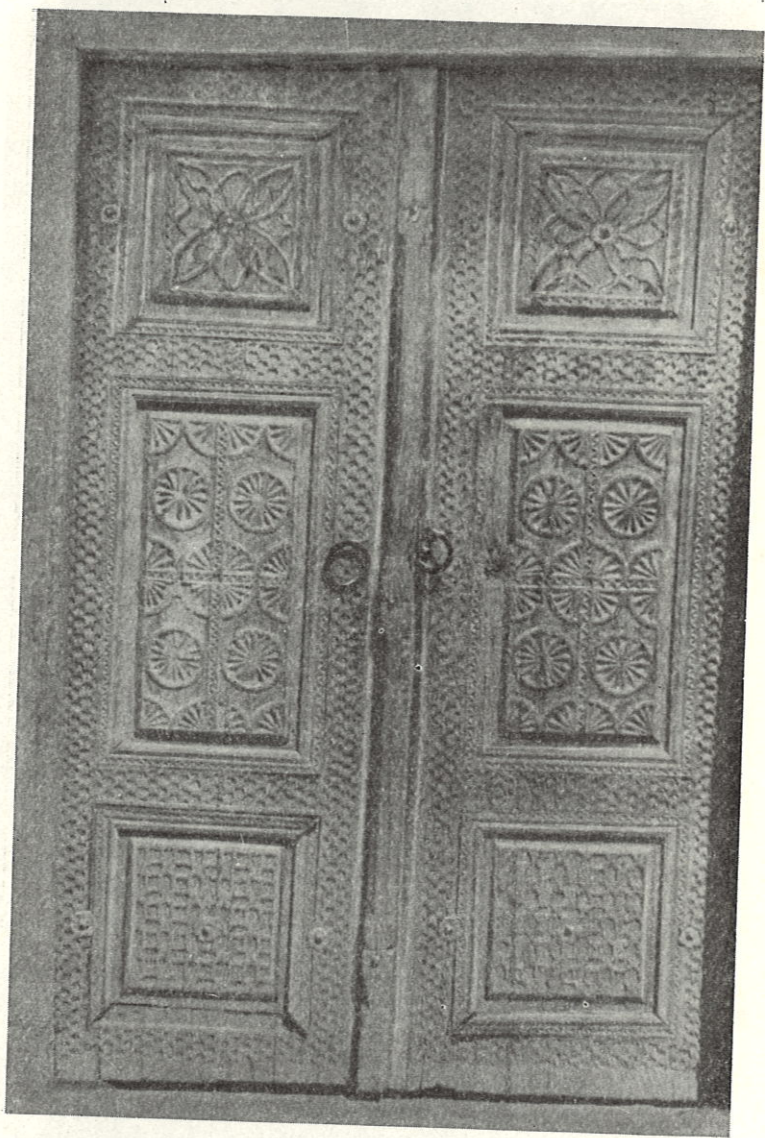
Рис. 7. Двухстворчатая ложнофиленчатая дверь (на поле створок, изготовленных по традиции из целых досок, набиты планки, ограничивающие филенки). Орнамент нефилленчатой двери (б. Сибзарская часть)
